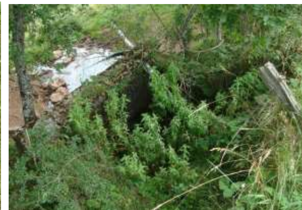
réservoir de l'autre côté de la route
