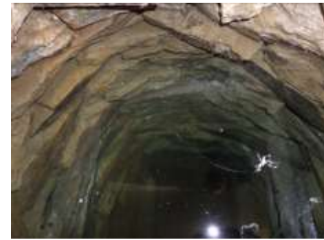
Aspect du puits (4m de profondeur)
